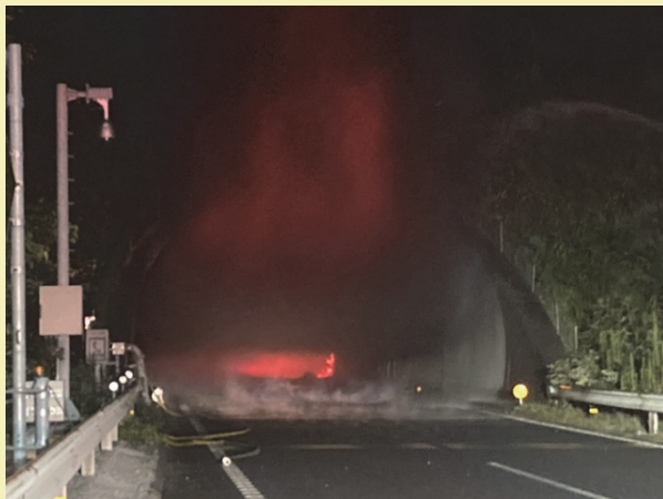
尼子山トンネルにおける火災の様子 (赤穂市消防本部提供)
